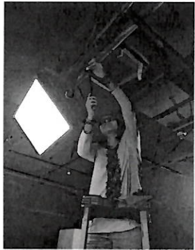
Cambio de clavijas a luminarias
