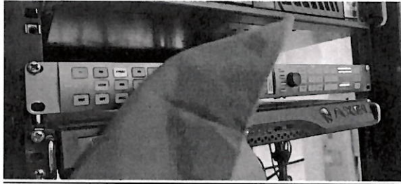
Limpeza al sistema de conversión de señales
