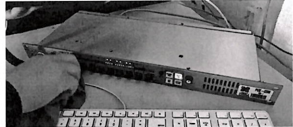
Limpeza a la intercomunicación con las otras cabinas
